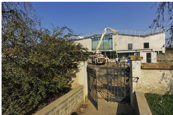
Le musée en cours de construction, printemps 2013 – Photo Doncourt
